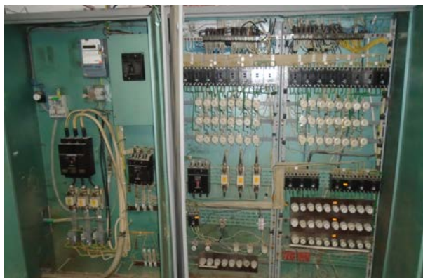
Фиг.24. Главно разпределително табло /ГРТ/ на сградата
