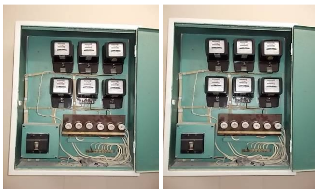
Фиг.25. Подтабла в коридор
